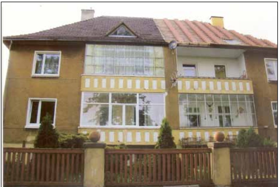
Tak wyglądało przed remontem
